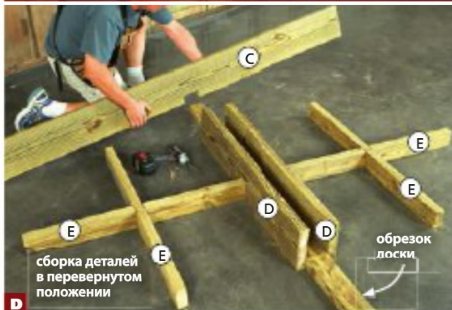
D Вставьте обрезок доски сечением 38×90 мм между двумя короткими балками D и двумя крестовинами из перекладин E. Наденьте на обрезок вырез поперечной балки C.
